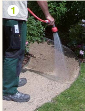
Schottertragschicht anfeuchten
