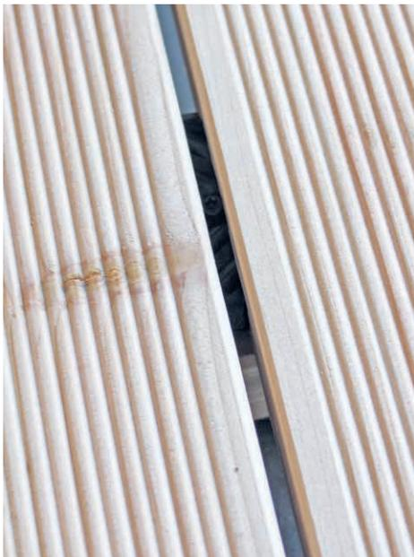
Die Dielenbefestigung ist vollständig in der Fuge verborgen. Hierdurch wird die begehbare Oberfläche nicht beschädigt.
